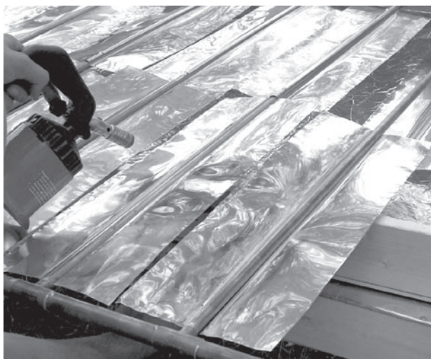
Sl: Spajanje krilca s bakrenom rešetkom postupkom lotanja
